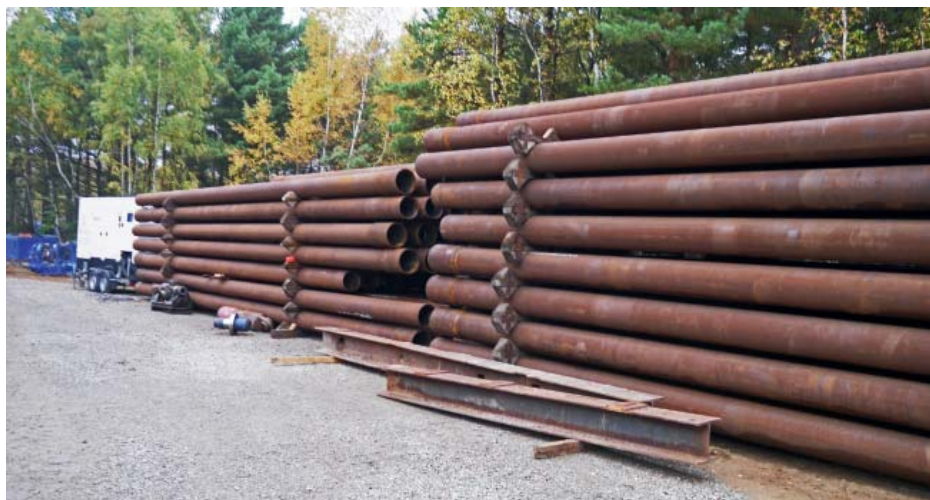
Fot. 2. Stalowy rurociąg DN 325
