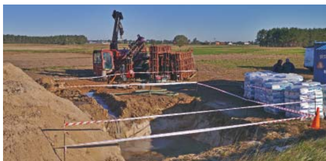
Fot. 4. Przewiert pod rzeką Wartą
